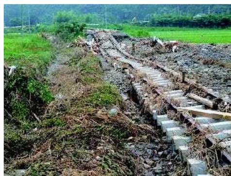
写真-1 鉄道盛土の河川洪水氾濫による被害（Tsubaki et al. 2016）
