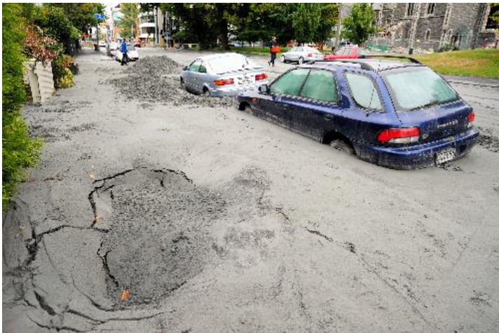
2011年2月 ニュージーランド地震 (引用:朝日新聞) 液状化現象で噴き出した砂に埋もれた車
